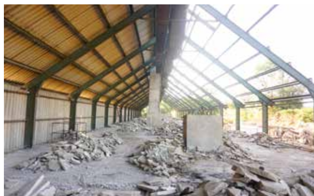
Abriss des alten Kuhstalls in Grünhainichen
