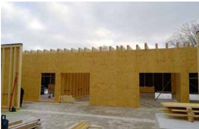
Anfang Dezember konnten die Holzwände des Schulgebäudes gestellt werden.
