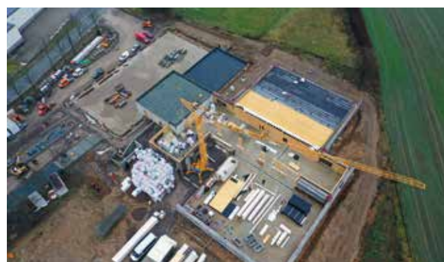
Der Grundschul-Neubau von oben. Vielen Dank an Herrn Dietmar Ender für die Drohnenaufnahmen.
