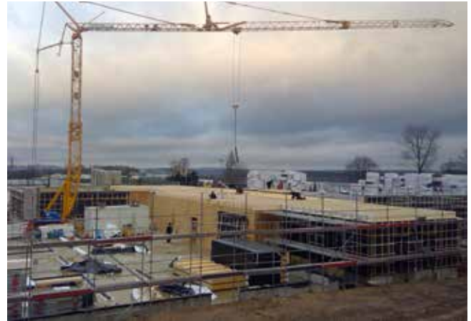
Der Fortschritt der Zimmererarbeiten war am 20.12.2021 deutlich erkennbar. Fotos: Robert Arnold
