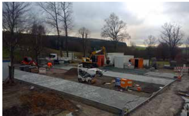
Auch der Bau der Parkplätze wurde begonnen.
