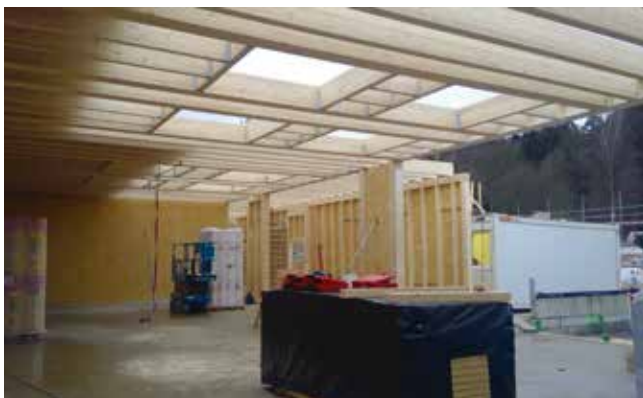
Ein Blick in den Speiseraum / Multifunktionsraum
